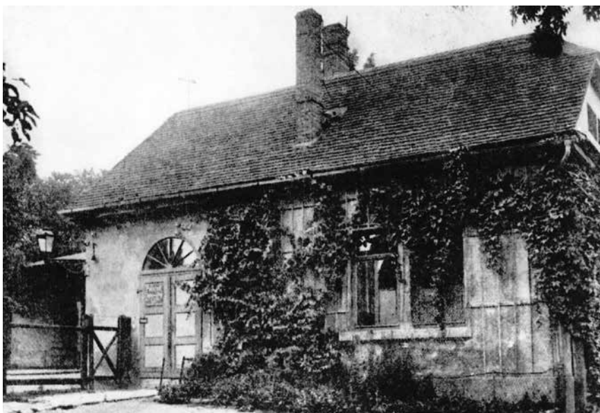
Abb. 5: Das Wohnhaus der historischen Thierarzneyschule am Heinrichsberg
