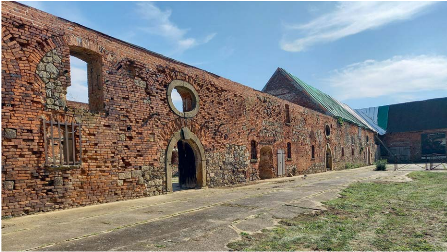
Abb. 6: Fassade des Ostflügels.
