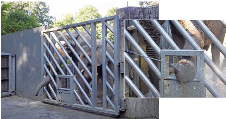
Abb. 3: Beim „protected contact“ trainieren Tierpfleger die Tiere, bestimmte Körperteile an einer speziell gestalteten Gitterwand vorzuzeigen, z. B. steckt der Bulle seinen Fuß durch eine spezielle Öffnung, sodass die Tierpfleger Fußpflegemaßnahmen durchführen können.
