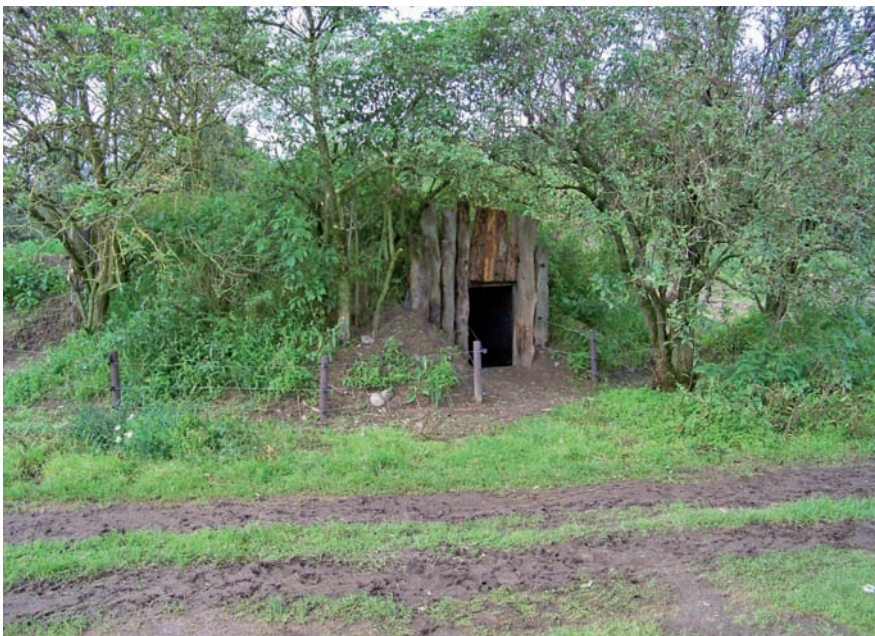
Abb. 3: Die Stallungen der Schweine sind als Hütten unter Erdhügeln beinahe unsichtbar in die Landschaft integriert.
